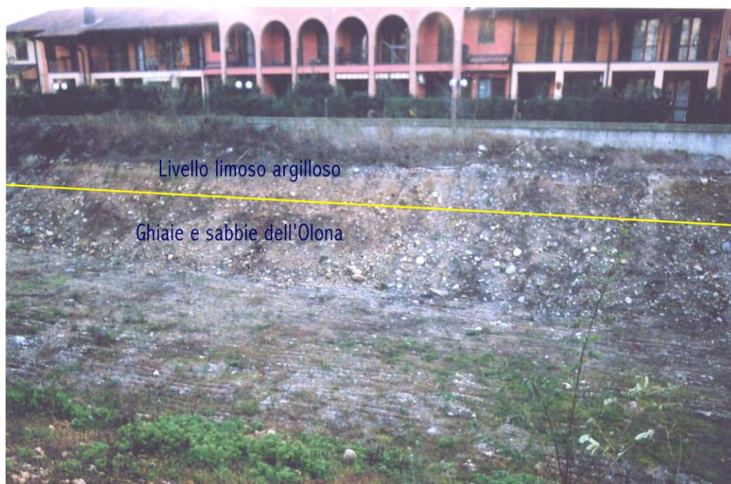
Figura 16 - Scavo di natura antropica eseguito in corrispondenza del nuovo insediamento abitativo di "Mulino Meraviglia".
