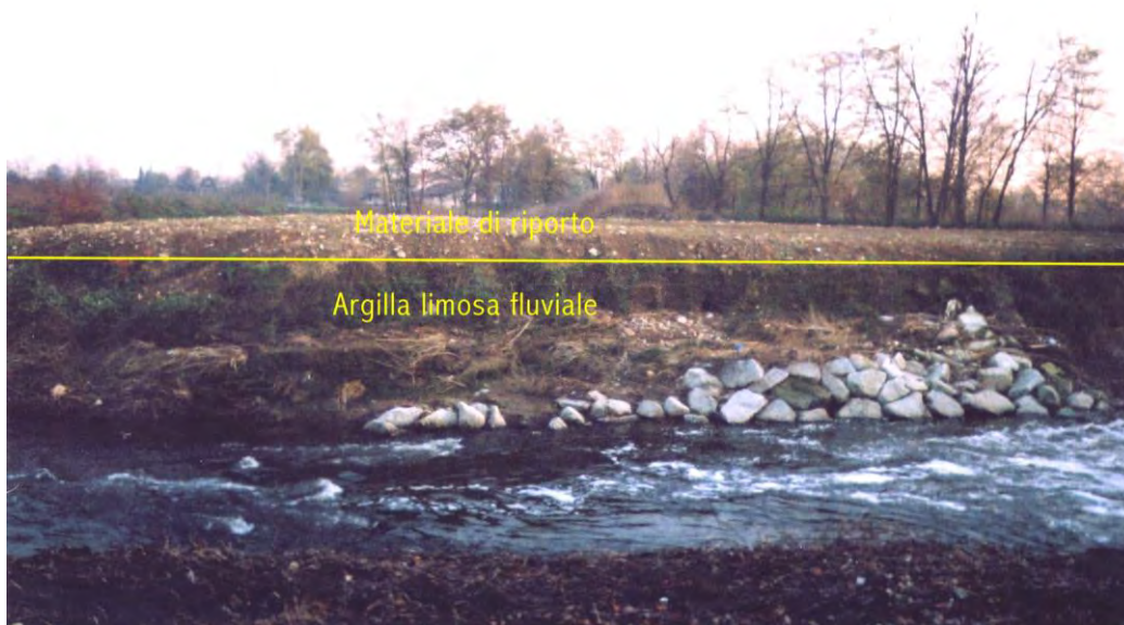
Figura 6 - Argine dell'Olona innalzato utilizzando materiale reperito in zona. La linea separa le alluvioni dell'Olona in basso, da una struttura antropica costituita da materiale ghiaioso sabbioso a matrice limosa.(Sinistra Idrografica)
