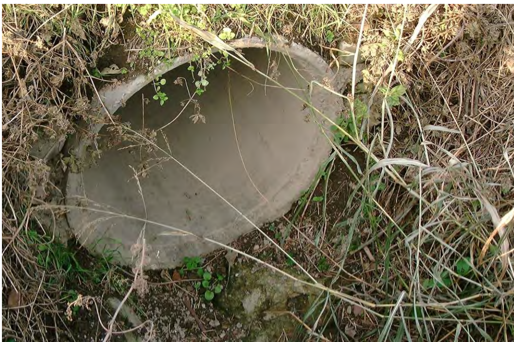
Figura 12 - Tubo in gress posto al di sotto di una strada sterrata. (Destra idrografica..)
